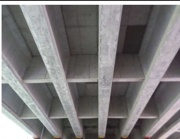
< 거더 및 가로보 전경 >
