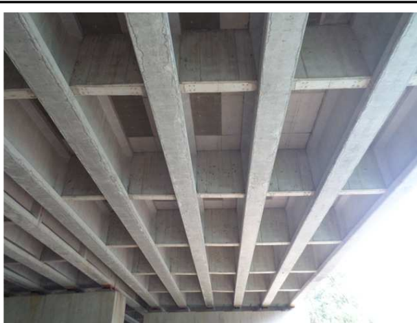
< 거더 및 가로보 전경 >
