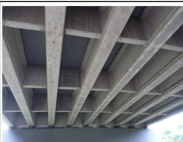
< 거더 및 가로보 전경 >
